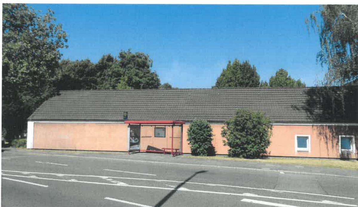
Abb. 13 Durch die Straßenplanung entfallender Gebäudeteil an der Warbruckstraße
