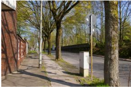
Vohwinkelstraße: Blick in Richtung Osten von der Tunnelstraße
