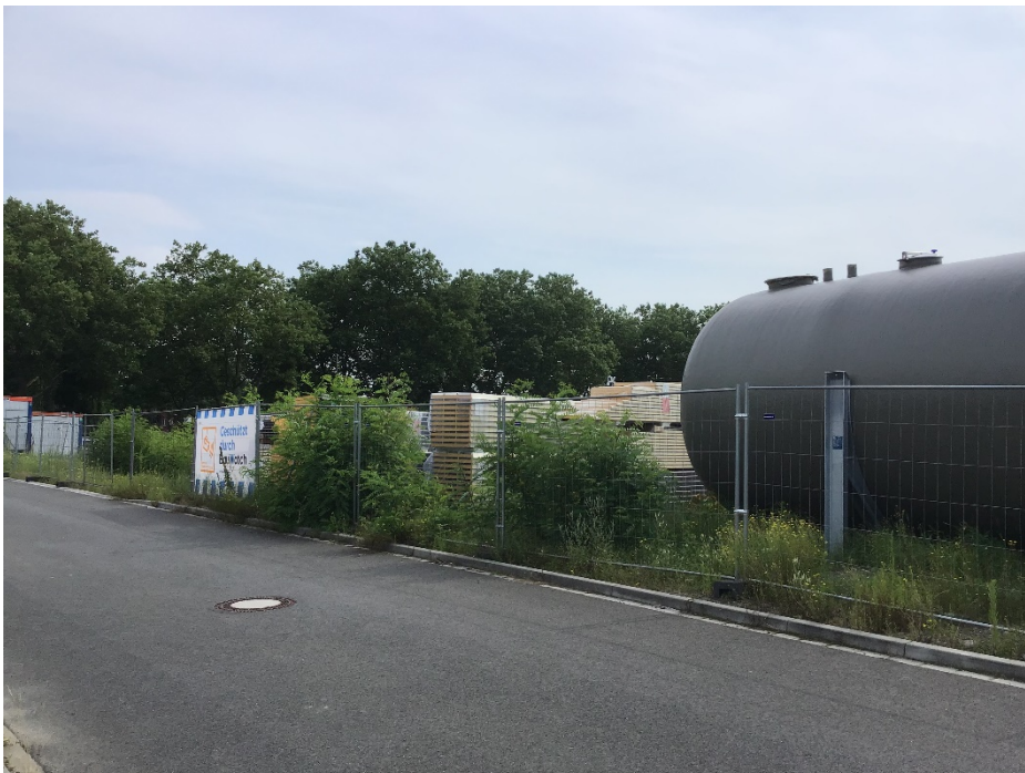
Abb. 4 Baustelleneinrichtungsflächen östlich der Straße „Im ZebraPark“
