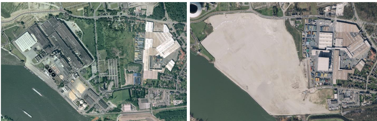
Abbildung 9: Gegenüberstellung von Luftbildaufnahmen (2006 vs. 2020) des Bereichs um die ehemalige Papierfabrik Walsum
